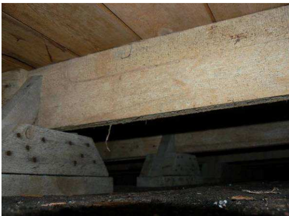
Obr. 10.: Sonda 3 - prvky podepření konstrukce pro vytvoření sklonu.
