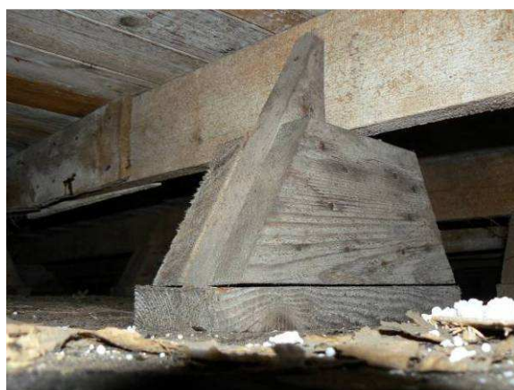
Obr. 14.: Sonda 5 - masivní stopy záteků i kondenzátu po celé ploše konstrukce.
