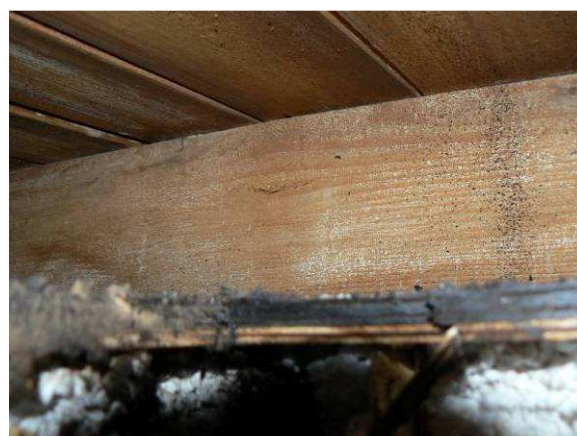
Obr. 7.: Sonda 2 - detail nosné fošny a záklopu.
