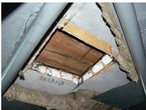
Obr. 8.: Sonda 3 otevřená ve stropu nad halou pavilonu.
