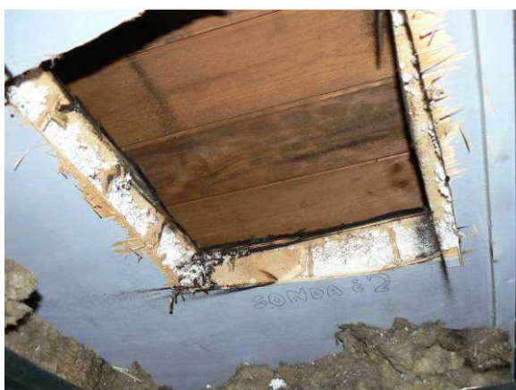
Obr. 6.: Sonda 2 otevřená ve stropu nad halou pavilonu.
