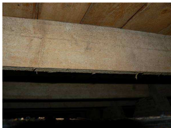
Obr. 5.: Sonda 1 - nosné fošny a záklop, na fošně je vidět suk přes celou výšku fošny a vodorovná trhlinka.
