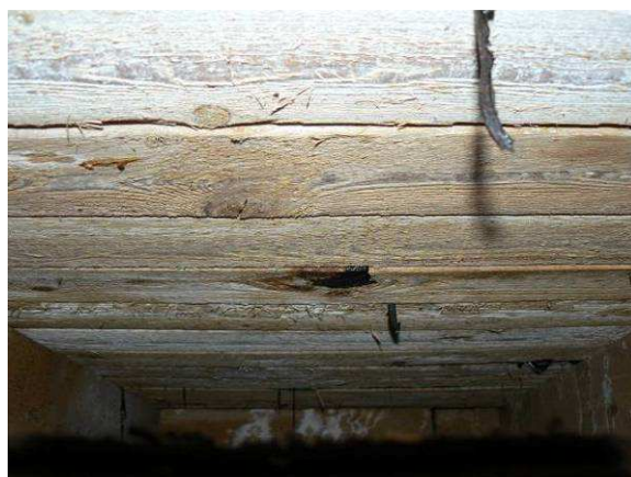
Obr. 19.: Sonda 6 - stopy zatékání srážkové vody jasně viditelné i na vzdálenějších prvcích konstrukce.
