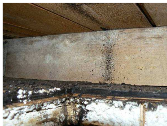
Obr. 9.: Sonda 3 - stopy na fošně naznačují občasnou kondenzaci vlhkosti na jejím povrchu.
