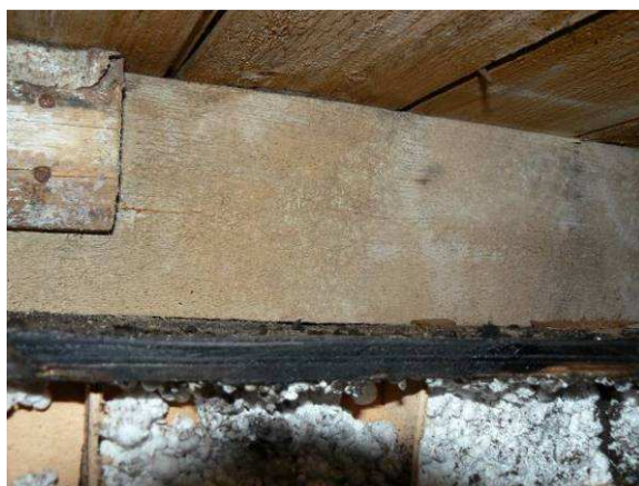
Obr. 12.: Sonda 4 - na fošně patrné jak záteky, tak stopy kondenzace.
