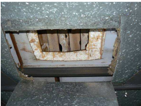
Obr. 16.: Sonda 6 otevřená ve stropu nad vstupním objektem.
