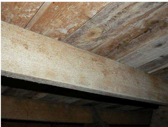
Obr. 15.: Sonda 5 - masivní stopy záteků i kondenzátu po celé ploše konstrukce.
